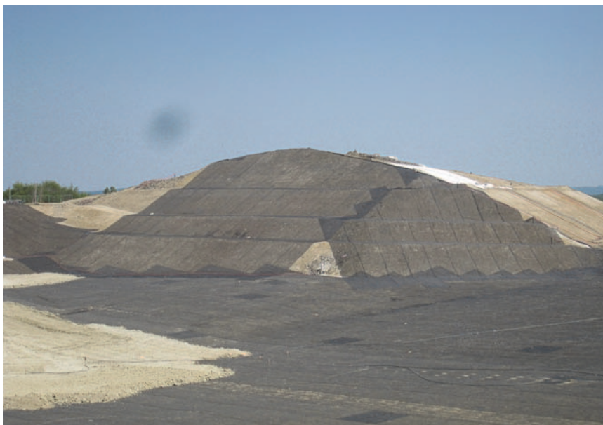
Figure 7. Mise en œuvre d'une géogridde de renforcement sous couche d'étanchéité passive dans le cadre de l'extension de l'ISDND de Crépy-en-Valois (planches K20).
