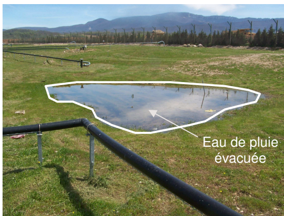
Figure 3. Cartographie d'une dépression de surface résultant d'importants tassements différentiels (a) illustration (b) représentation des altitudes à partir d'une discrétisation en grilles élémentaires de 2 * 2 m.
