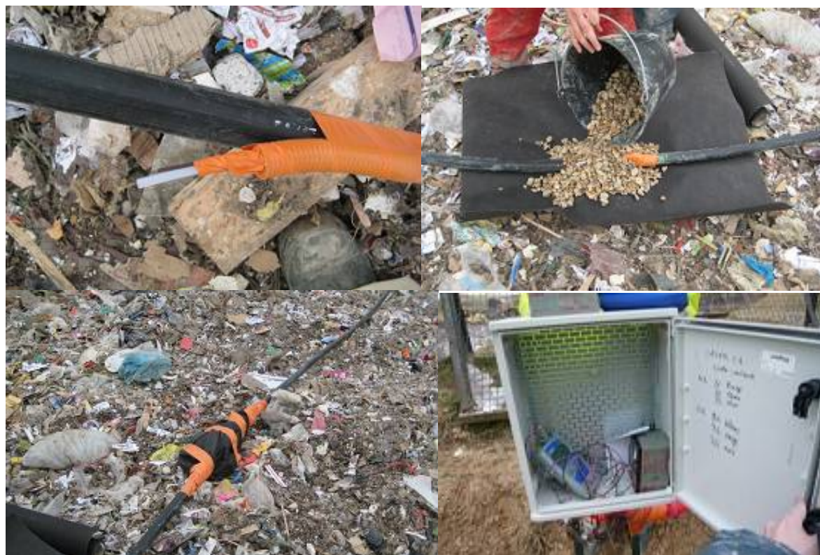
Figure 35 : Sondes de température et de suivi de la composition en gaz
