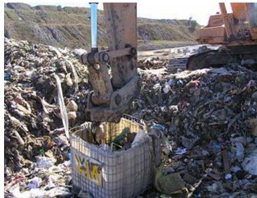
Figure 91 : Compactage de déchet à l'intérieur d'un lysimètre à l'aide de la pelle mécanique
