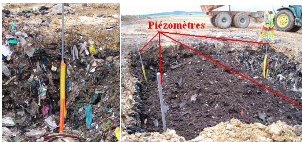
Figure 94 : Installation des piézomètres au niveau des chambres d'injection
