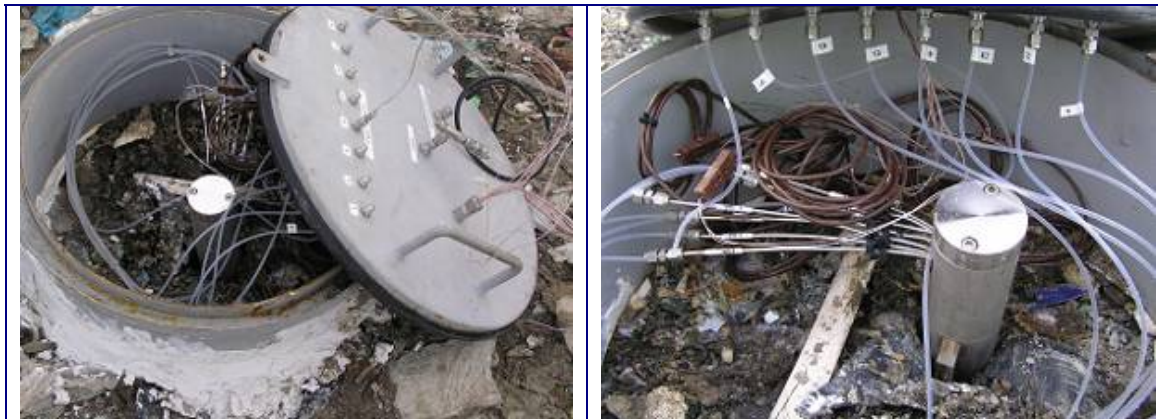
Figure 41 : Photos de la chambre positionnée au-dessus de la sonde
