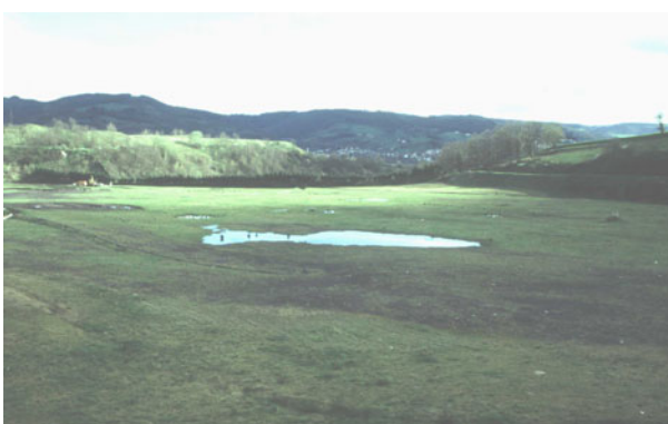
Figure 9. Illustration des tassements différentiels sur site (a) formation de dépressions sur la couverture de casier (b) apparition de points bas le long du réseau de drainage des biogaz (Source : ANTEA).
