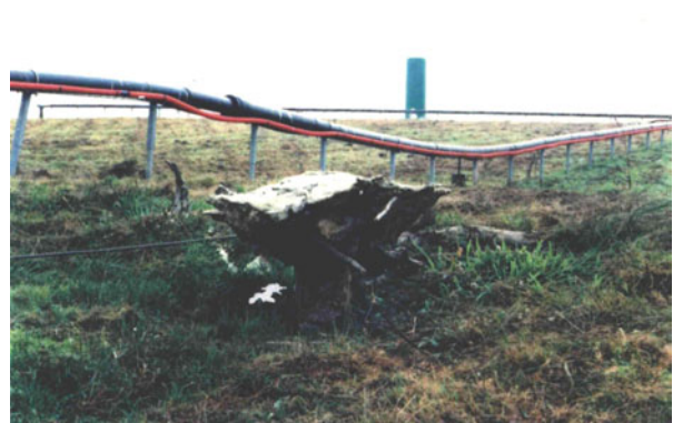
Figure 9. Illustration des tassements différentiels sur site (a) formation de dépressions sur la couverture de casier (b) apparition de points bas le long du réseau de drainage des biogaz (Source : ANTEA).
