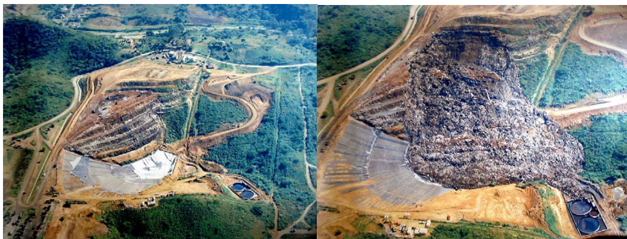
Figure 40. Photo aérienne du talus de Bulbul Drive (Afrique du Sud) avant et après rupture (Brink et al., 1999)
