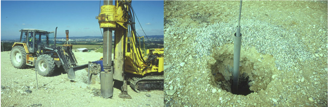
Figure 22. (a) Mise en place du gravier annulaire immédiatement après forage (b) Zoom sur le trou de forage après installation du tubage PVC et du train de tige flottante (CSD de Chatuzange).
